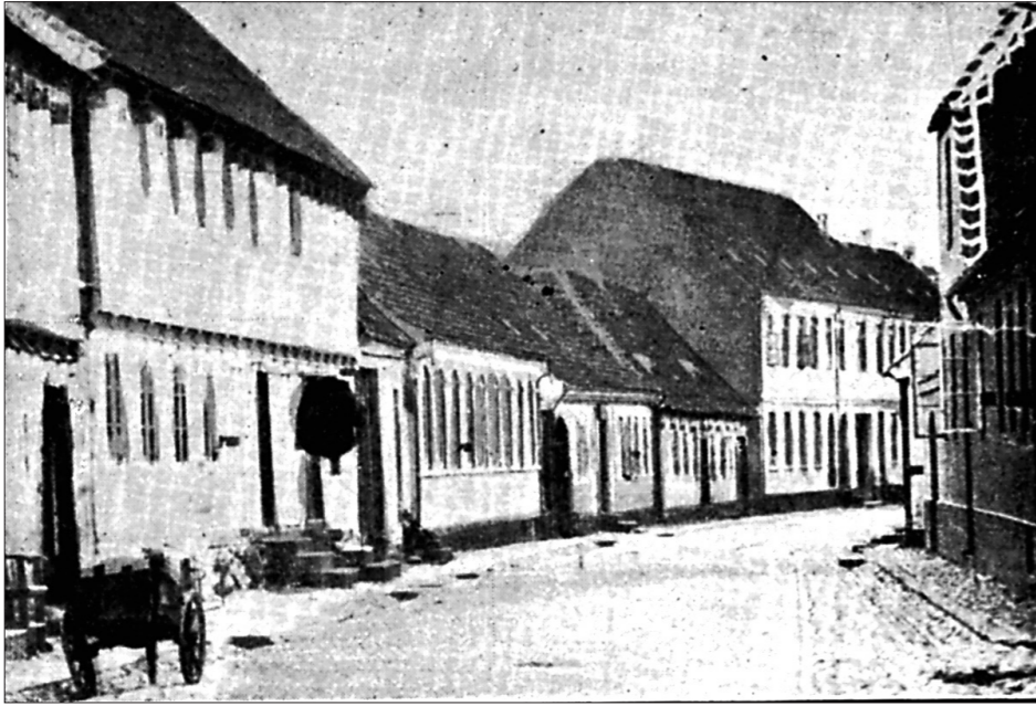
Storegades østligste del omkring 1864. Ejendommen til venstre er "Hennigs" nuværende Grenaa Handels- og Landbrugsbank.
