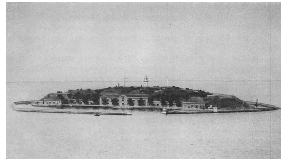
Middelgrundsfortet opførtes 1890-95 på en vanddybde af ca. 7 m og for en sum af ca. 9 mill. kr. - et på det tidspunkt anseligt beløb. Dets bestykning består af både svært og let artilleri foruden projektører, afstandsmålere m.m.
