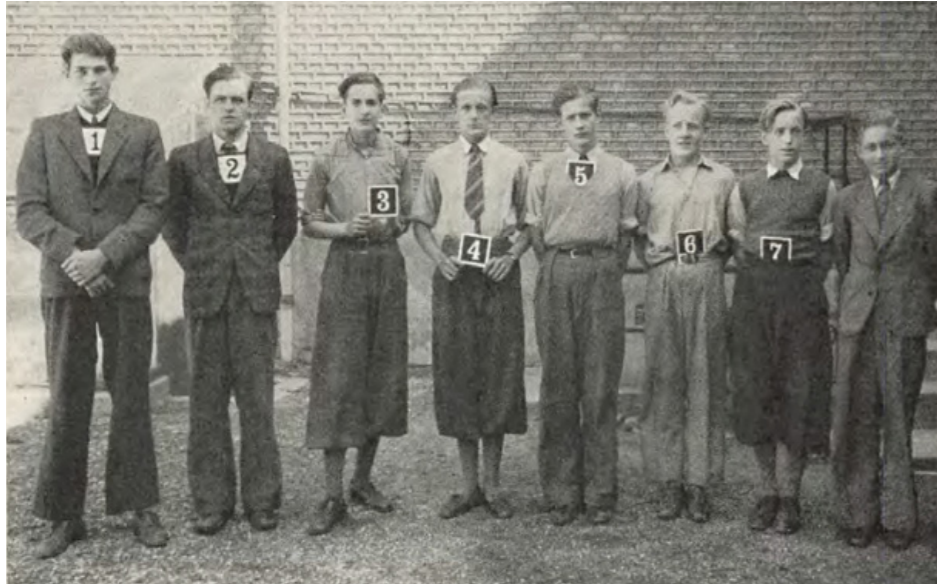
»Churchill-Klubben« i Ålborg, otte raske skole drenge som - hjulpet af tre voksne ledere, der ikke ses på billedet - lærte mange ældre, hvad vi danske havde at gøre, mens fjenden var i landet: skade ham efter evne, i småt som i stort! De begyndte »arbejdet« i januar 1942 og anholdtes den 8. maj, da de havde ca. 25 sabotagehandlinger på samvittigheden. Dommen faldt den 11. juni: To af drengene fik hver 3 års, en 2½ års, to hver 2 års og to hver 1 års fængsel. Den ottende slap på grund af sin unge alder for straf. Takket være hurtig indgriben fra de danske myndigheders side var det lykkedes at få »forbryderne« dømt ved dansk ret.
