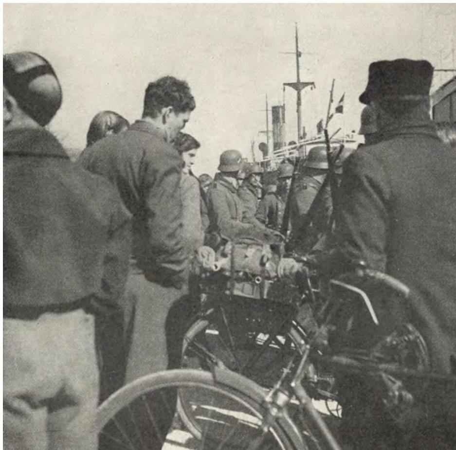
Efter landsætningen, marcherer tropperne op på kajen. På dette tidspunkt har kapitulationen allerede fundet sted, og »beskytterne« kan - med en skare af nysgerrige efter sig - gå i gang med deres velsignelsesrige virksomhed.
