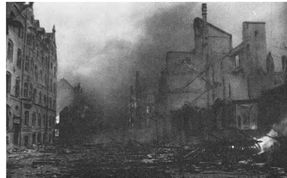
Man er ved at få herredømme over ilden på Maglekildevej, men ødelæggelsen er total.
