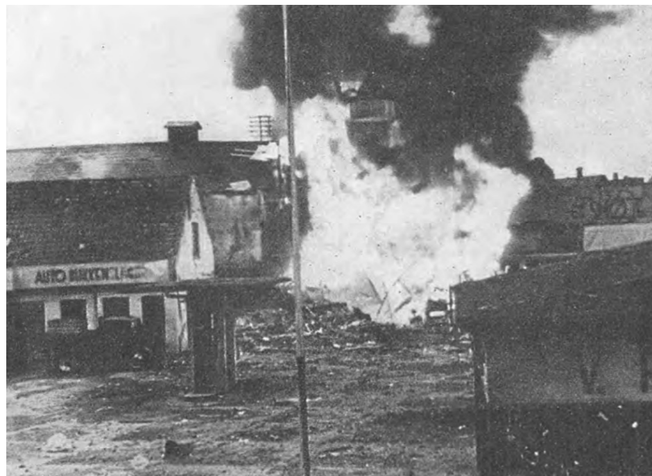
Holm Jensens Reparationsværksted for automobiler blev sprængt i luften den 11. juni 1944. Om natten var Odense Esso Service Station blevet angrebet, hvor 10 lastmotorvogne ødelagdes. Sabotørerne, der skulde tage sig af Holm Jensens virksomhed, holdt tidligt om morgenen en af Elektricitetsværkets biler op, tvang dens to mand ud af vognen og tog deres kasketter. Klokkeren var da 4,45. Tyve minutter senere røg reparationsværkstedet i luften, hvorved to sabotagevagter mistede livet.
