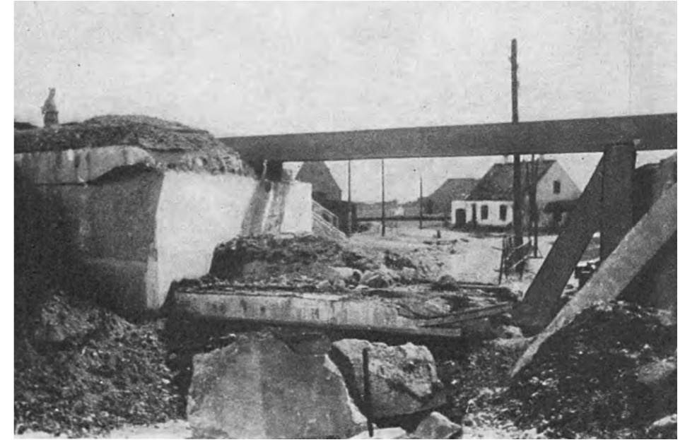
Her ser man jernbanebroen, ved Jerne nær Esbjerg. Af den gamle bro er der intet tilbage. En interimistisk bro af stålbjælker er blevet bygget, men den giver ingen sikker drift - og kan let lokke til nye attentater!
