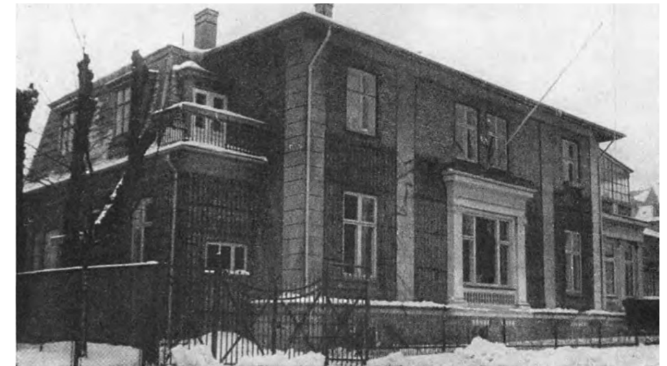
Den sovjetrussiske gesandtskabsbygning på Frydendalsvej.
