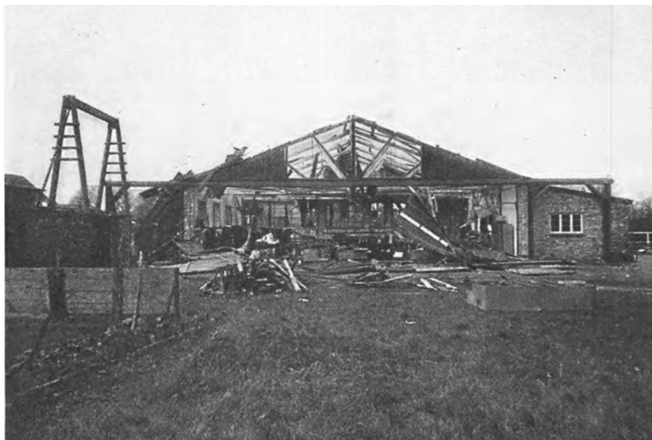
En af de ødelagte hangarer fra Flyvertroppernes Reparationsværksted på Kløvermarksvej, efter at BOPA havde aflagt virksomheden besøg den 6. oktober 1943.
