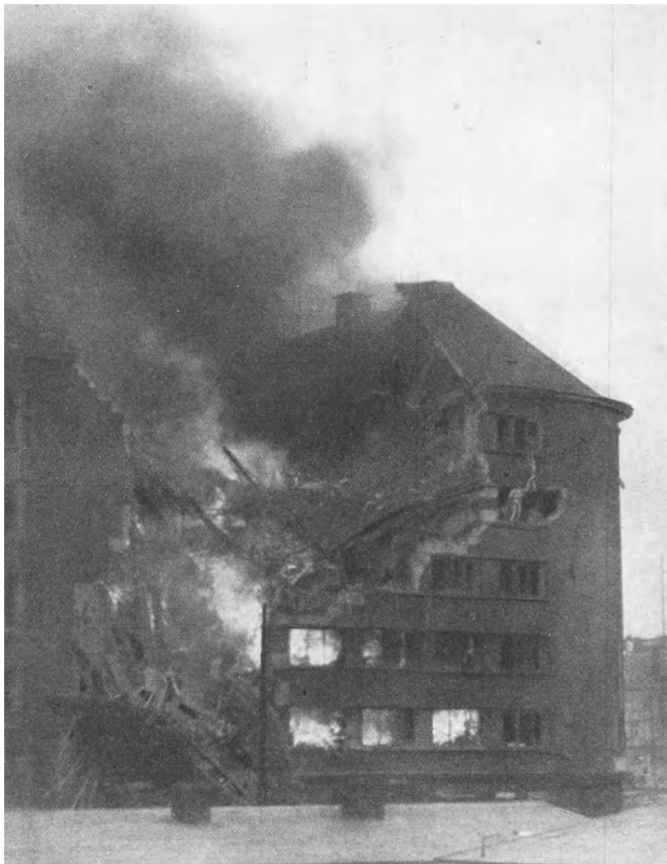
En R.A.F.-bombe har flænget hele Shell-Huset op, og ild og røg vælder ud af bygningen.
