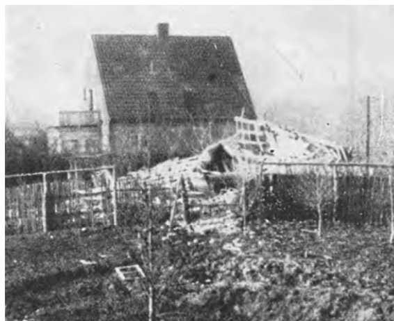
Da Brøndums bande havde bæreret Kisum Bakke med deres besøg, var der ikke store ting tilbage af hele herligheden. Vandalerne havde fået udløsning for deres trang til ødelæggelse, og nabovillaen så betuttet ned på en bunke murbrokker og hvidt kalkstøv, der lå, hvor huset før havde stået.
