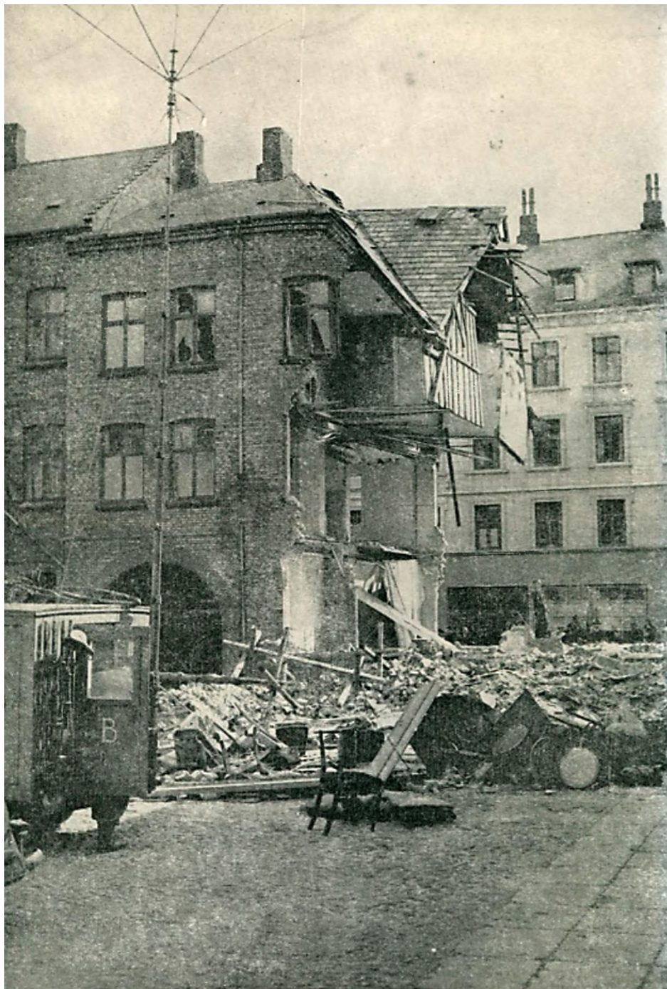
Ved en en-mands-aktion blev Gestapos hovedkvarter i Esbjerg, Højskolehjemmet i Skolegade, lagt i ruiner i april 1945. Her ses en fløj af bygningen. Ved Eksplosionen omkom 3-4 Gestapofolk.
