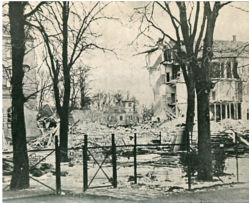
Billede fra fabriken TOROTOR, hvor 80 bevæbnede sabotører trængte ind efter at have nedkæmpet en bunkers ved indgangen. TOROTØR arbejdede for tyskerne, men fabrikere dog ikke, som man troede, V-våben. Hele den midterste del af bygningen er som blæst bort og fabriken fuldstændig uanvendelig.
