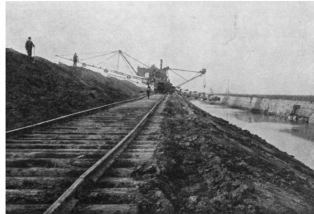
Gravemaskine med indstillelig transportør. Dige og fyldgrav. Fra digeanlægget for marsken ved Ribe, 1911.
